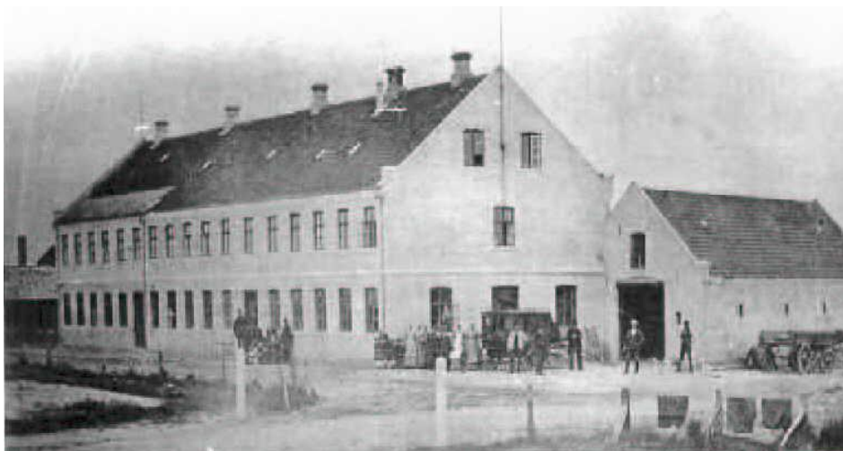
Hjørnet af Stormgade og Havnegade 1877 med Hotel Spangsbjerg . Gaderne er afgrænset med pæle og enkelte steder med hegn. Den lukkede vogn er til at hente gæster ved banegården, så de ikke skulle gå ad de plørede gader. ( Esbjerg Byhistoriske Arkiv )
